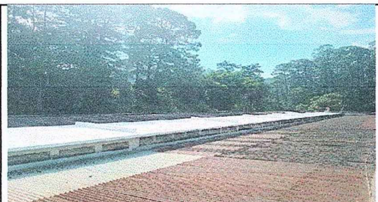
Foto 1: Impermeabilización completa de la losa del módulo de talleres industriales y laboratorios.
