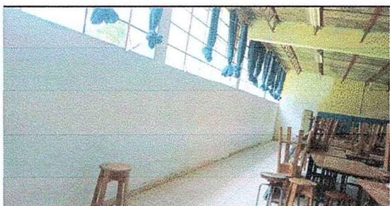
Foto 3: Paredes tratadas y recuperadas previo a su aplicación de pintura.
