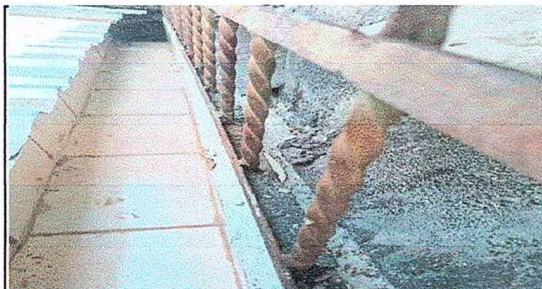
Foto 2: Vista lateral del azulejo colocado en el canal del techo, para evacuar el agua y evitar la infiltración.
